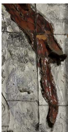
Figure da 3 a 6- Lacune materiche rilevate prima dello smontaggio dell'opera; si osserva la perdita di materiale in corrispondenza dei punti di contatto tra le formelle.
