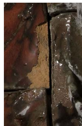
Figure da 3 a 6- Lacune materiche rilevate prima dello smontaggio dell'opera; si osserva la perdita di materiale in corrispondenza dei punti di contatto tra le formelle.
