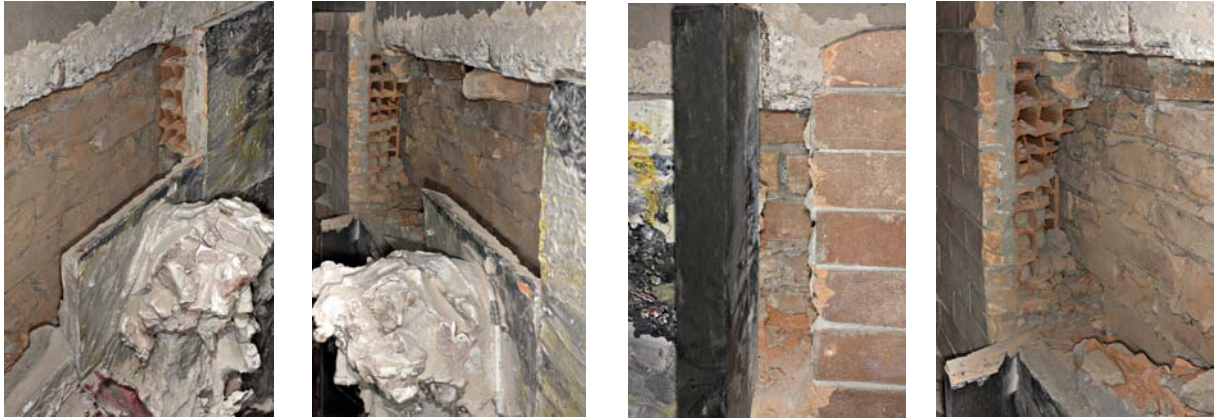
Figure da 7 a 10- Fasi dello smontaggio dell'altorilievo. È chiaramente visibile la struttura muraria composta da: parete esterna in mattoni pieni di una testa faccia vista, muratura in forati, malta cementizia, formelle in terracotta. La terza immagine da sinistra mostra una porzione di una delle due pesanti spallette di serpentino che fungevano da cornice, anch'esse rimosse nelle operazioni di smontaggio.
