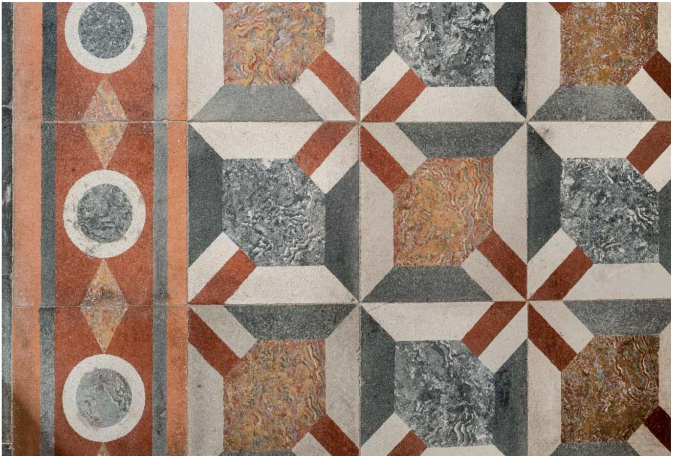
**Foto 2 e 3: Villa Corazza ora Levantini: particolare del pavimento in mattonelle di cemento,** ancora oggi esistente ed imitante gli intarsi di marmo, posto al piano terreno, nel salotto di ricevimento; a confronto il campione che lo pubblicizza nel depliant illustrativo del 1885-90 della Società Anonima per la calce idraulica, ecc di Reggio Emilia (numm. 55 e 65 del campionario)
