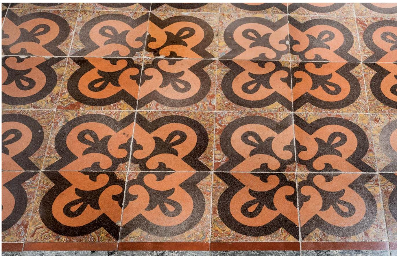
**Foto 6 e 7: Villa Corazza ora Levantini: particolare del pavimento in mattonelle di cemento,** ancora oggi esistente ed imitante gli intarsi di marmo, posto al piano terreno, nella sala da pranzo invernale; a confronto il campione che lo pubblicizza nel depliant illustrativo del 1885-90 della Società Anonima per la calce idraulica, ecc di Reggio Emilia (num. 111 del campionario)
