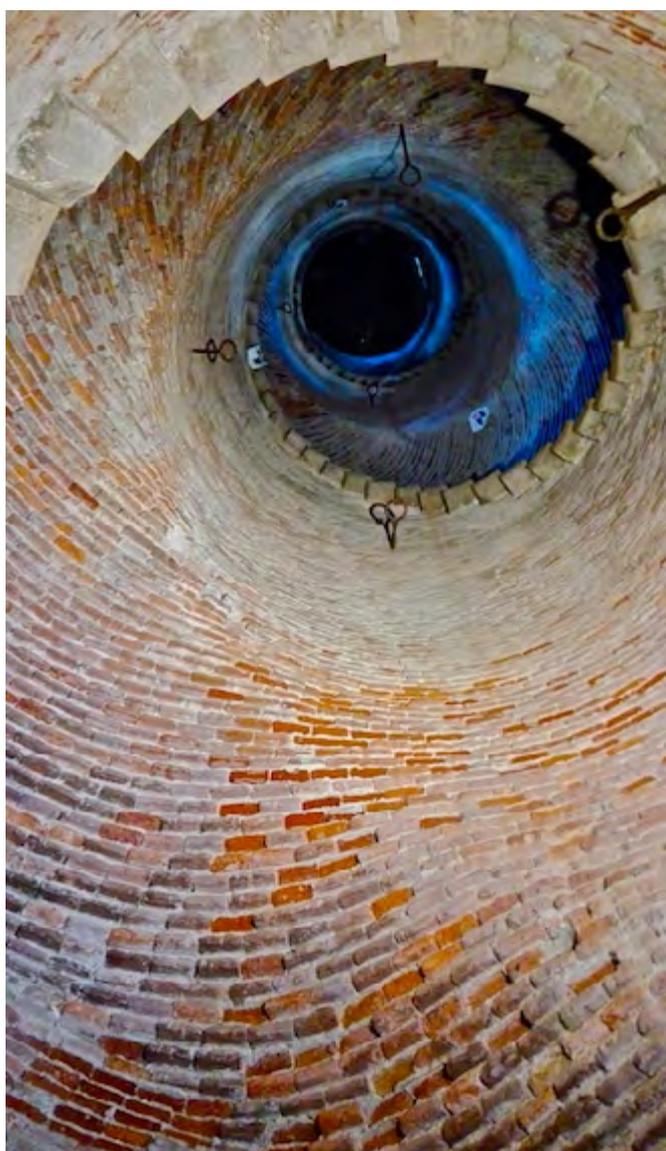
**Scala elicoidale:** autoportante in laterizio, interno della torre campanaria - foto archivio "AdC"
