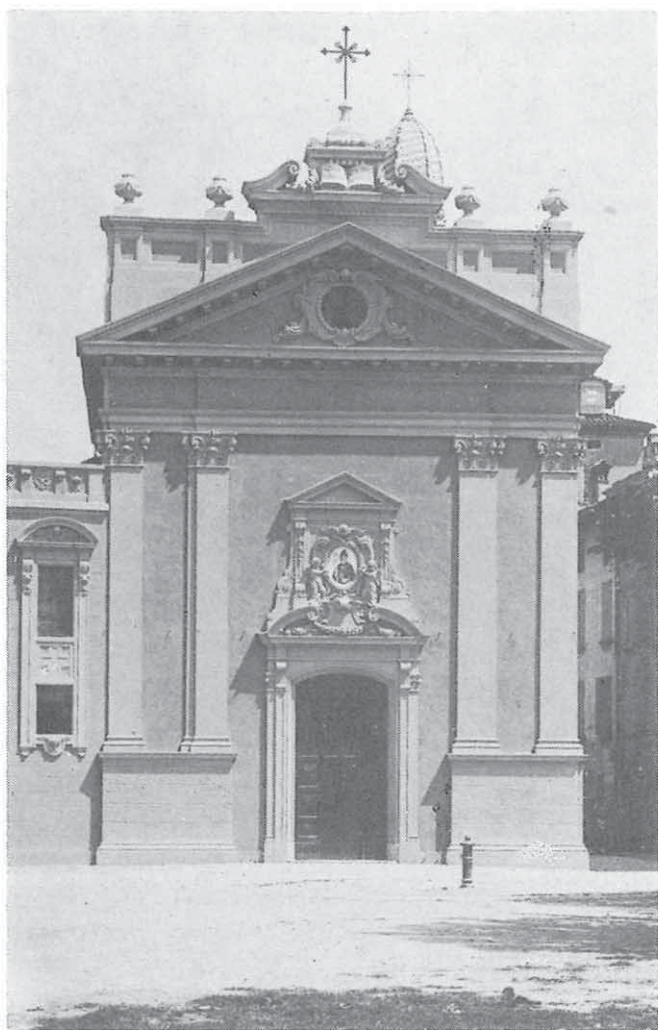
Fig. 9 - La facciata rifatta nel 1930 dall'arch. Sorgato. Si notino i bugnati, ora eliminati, dei due zoccoli.
