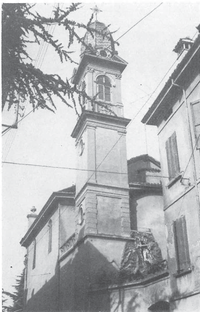
Fig. 10 - 1930 — Il campanile della Chiesa dopo la sopraelevazione dell'Arch. Sorgato. La parte basale era liscia, il secondo piano era decorato con bugnati, ora sostituiti da lesene che scendono fino a terra.
